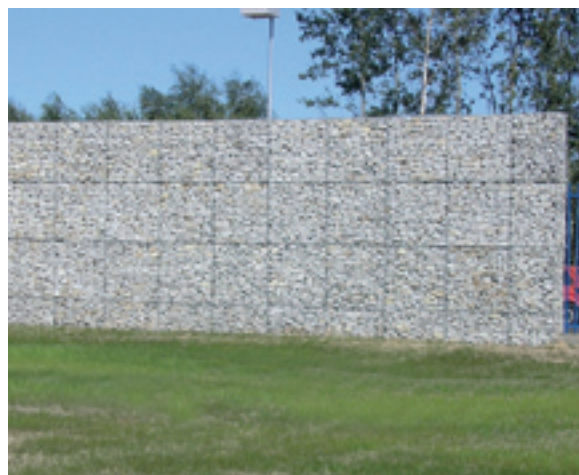
Firma Gillette (Łódź) – Polska – Gabiony
