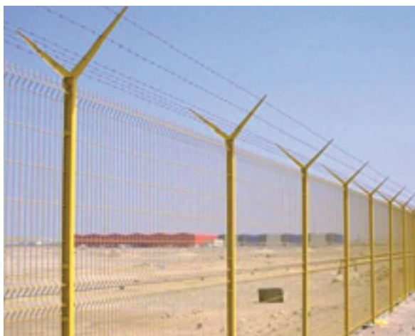
GIC Industrial Site (Abu Dhabi) – Zjednoczone Emiraty Arabskie – Nylofor® 3D
